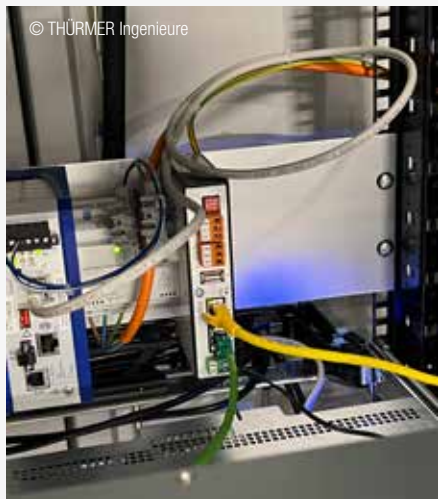
Gesicherte Datenausleitung über die Data Box. Secured data transfer via the Data Box.
